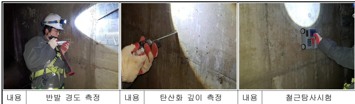
【사진 15.5】 양주지축 재료시험 전경
